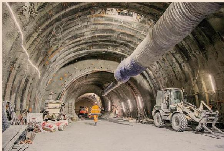
Versante francese. Una immagine dello scavo realizzato con metodo tradizionale
