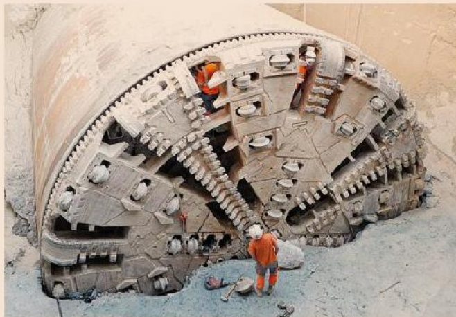
Alta velocità Uno dei cantieri della linea Lione Torino della Tav
