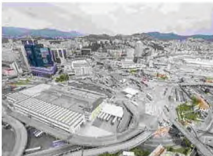
Il nodo di San Benigno è una delle opere collegate alla Gronda
