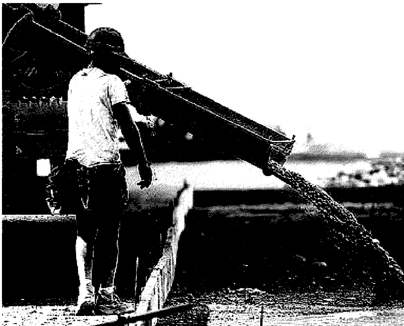
LAVORI Il nuovo sedime ferroviario prosegue per ora verso il T2
