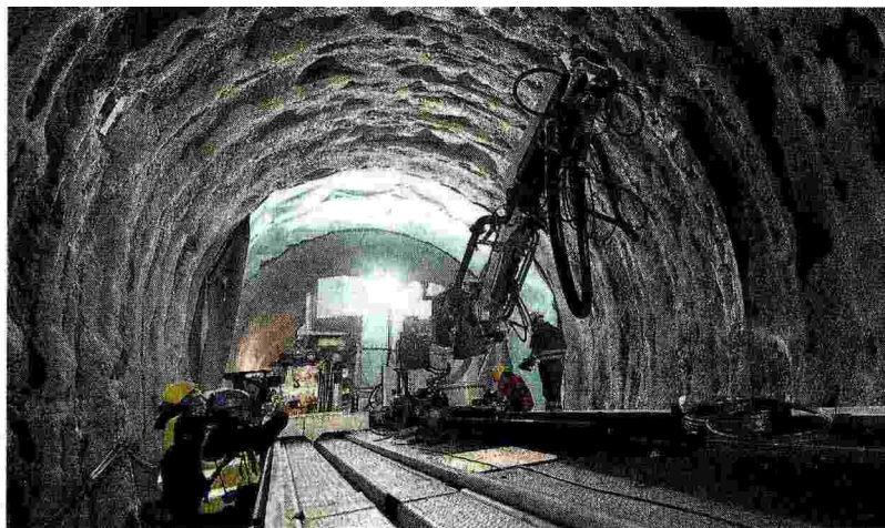
I lavori per lo scavo del tunnel esplorativo di Chiomonte
