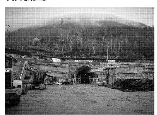
**CHIOMONTE** Continuano i lavori per la realizzazione del tunnel geognostico. Ľanno prossimo è previsto invece l'inizio degli scavi per la costruzione del tunnel di base
